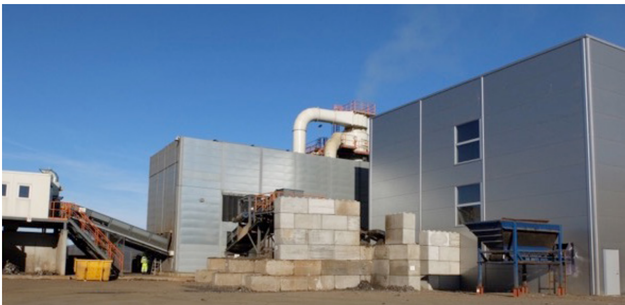
Figur 5: Shredderanlegg for neddeling og separering av kompleksjern. Foto: Fredrik Gaustad
