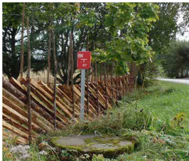
Figur 8: Alle brannvannuttak skal merkes.
