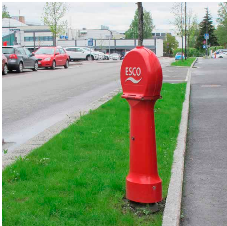
Figur 36: Hydranter gir rask tilkobling til vannledningsnettet, men krever mer vedlikehold enn brannkummer.
