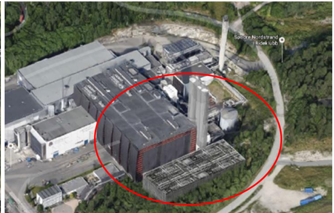
Klemetsrudanlegget med karbonfangst og ny ovnslinje (L4)
